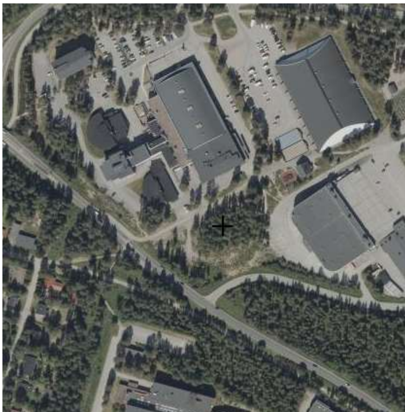
Kuva 1. Tuleva rakennuspaikka on kuvan keskellä (Kuva 1 Maanmittauslaitos).
